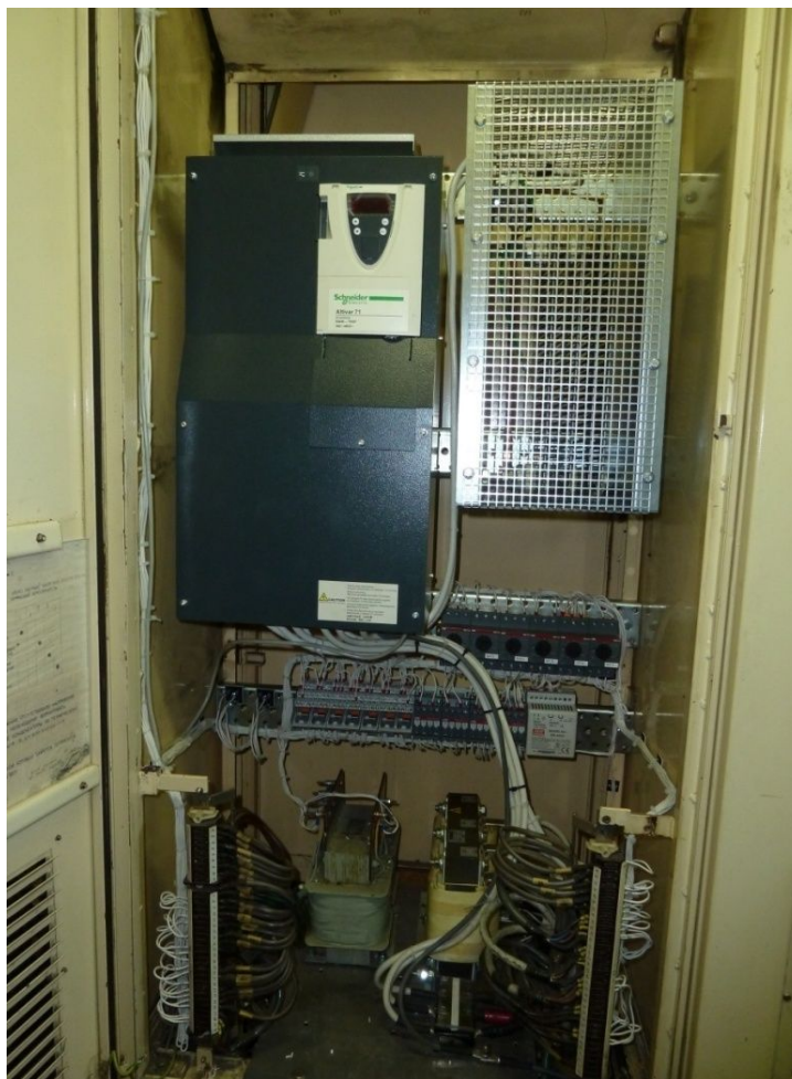
Рис. 7. Размещение нового оборудование в шкафу электроавтоматики.
